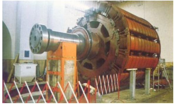
▪ rotore con in primo piano il giuntolato turbina
