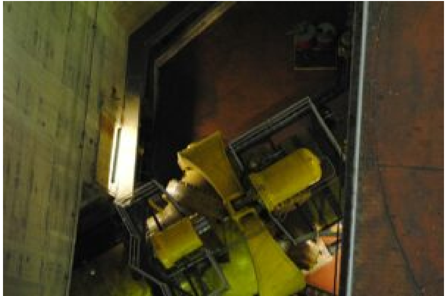
la valvola posta a monte della turbina e che intercetta l'acqua della condotta
